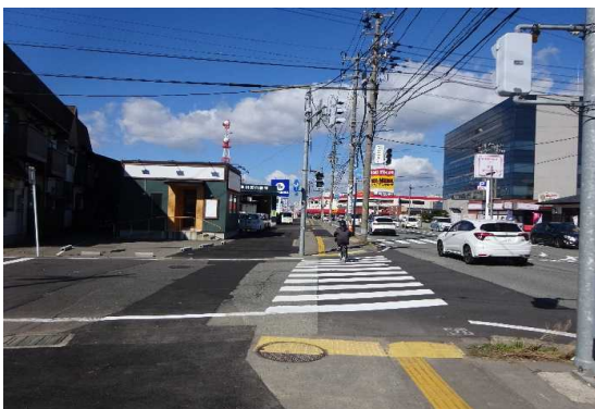
【進捗状況】 新屋土崎線(秋田市)
